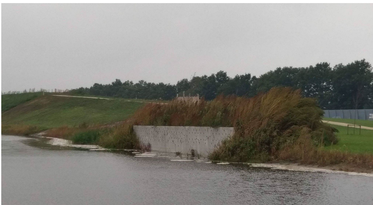
Fig. 5.5.22 - Imagine de ansamblu din cadrul Crescentpark în care poate fi observat un element al structurii hidrotehnice, realizat din beton, care înglobează și o serie de cavități special create pentru cuibărire pentru una dintre speciile de păsări al cărei habitat se suprapune cu zona orașului Harderwijk Sursă: arhiva RPR Birou de studii contemporane
