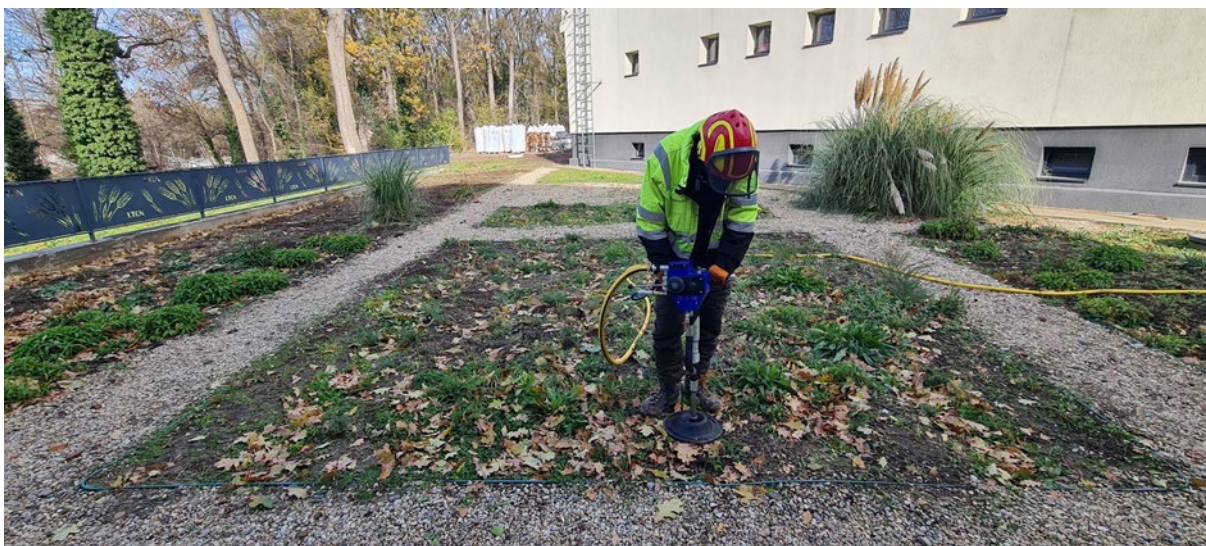
Fig. A1.7 - Exemplificare referitoare la compactarea solului prin injectarea substratului cu aer comprimat
