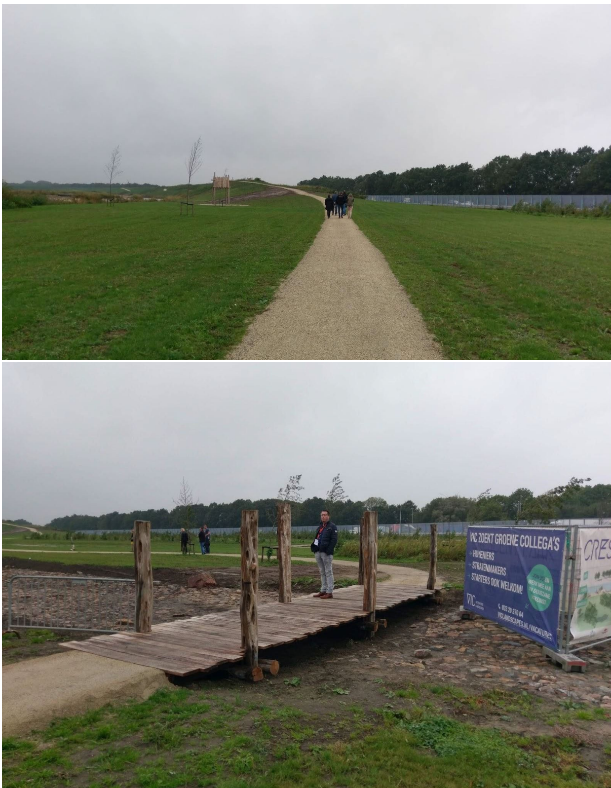
Fig. 5.5.11 - Imagini de ansamblu a circulațiilor principale perimetrare din cadrul Crescentpark: (sus) se poate observa conformația generală a aleilor realizate din pietriș stabilizat; (jos) podeț înglobat de circulația principală pentru traversarea în condiții de siguranță a zonelor inundabile din cadrul spațiului verde
