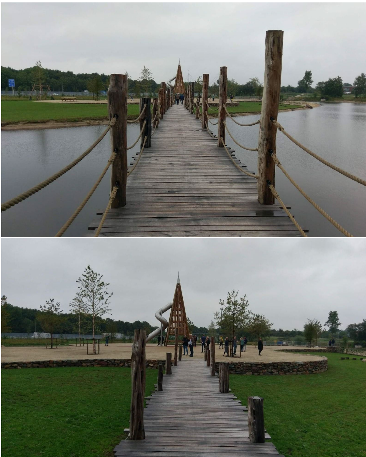
Fig. 5.5.12 - Imagini de ansamblu cu circulațiile principale din zona centrală a Crescentpark, realizate din lemn: (sus) conformația acestei circulații la traversarea peste apă; (jos) conformația acestei circulații la traversarea peste zonelor verzi
