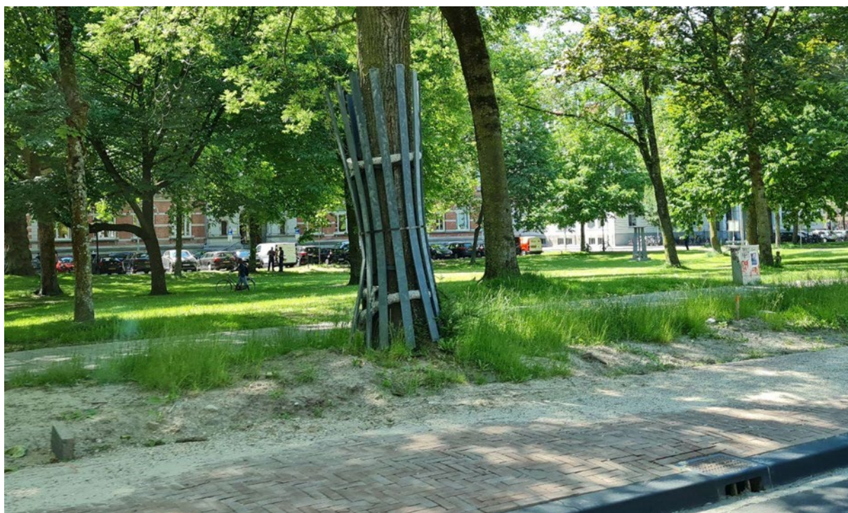
Fig. A1.13 - Exemplu referitor la protejarea trunchiurilor arborilor pe parcursul realizării unor intervenții de amenajare: platbande metalice aplicate peste odgoane
