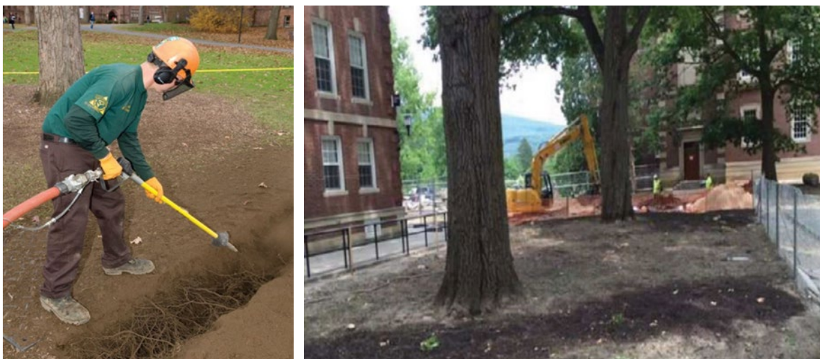
Fig. A1.12 - Exemplificare referitoare la utilizarea sistemelor de tip AirSpade pentru intervenții în Zona de Protecție a Arborelui (ZPA) pe parcursul lucrărilor de amenajare: (stânga) excavarea sistemului radicular fără afectarea rădăcinilor arborelui prin rupere sau tăiere; (dreapta) acoperirea rădăcinilor după finalizarea intervențiilor punctuale
