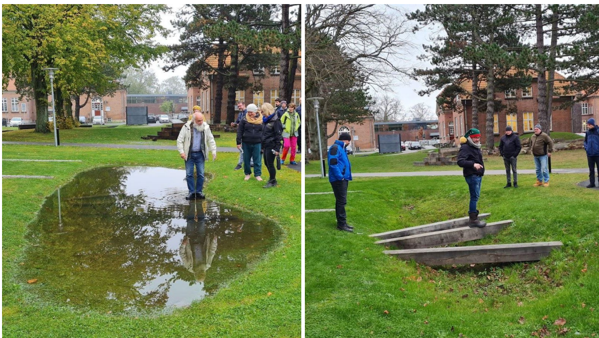
Fig. 5.2.2 - Exemplu referitor la conformația bazinelor de retenție din cadrul SPARK: (stânga, septembrie 2022) imagine cu bazinul de retenție într-o perioadă de maxim pentru aportul de apă provenită din precipitații; (dreapta, decembrie 2022) imagine cu bazinul de retenție într-o perioadă fără precipitații, în cadrul căreia sunt vizibile echipamentele utilizate în terapii pentru recuperarea locomotorie a pacienților Centrului de Reabilitare Marselisborg
