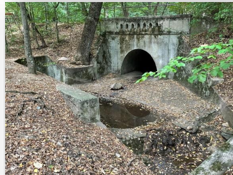
6 – Canal de colectare a apelor pluviale (în partea de vest a orașului Pitești)
