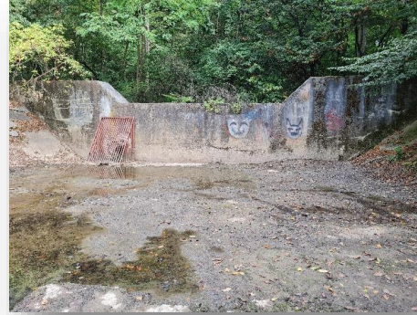
4 – Canal de colectare a apelor pluviale (în partea de vest a orașului Pitești)
