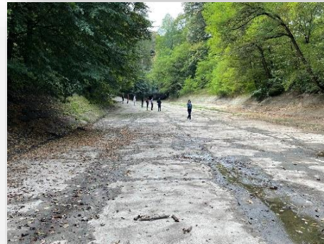
5 – Canal de colectare a apelor pluviale (în partea de vest a orașului Pitești)
