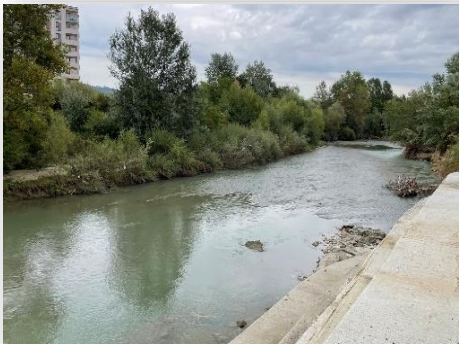
3 - Râul Ialomița – lucrări de consolidare a malurilor, realizate pentru protecția drumurilor
