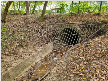
3 -Canal de colectare a apelor pluviale (în partea de vest a orașului Pitești)
