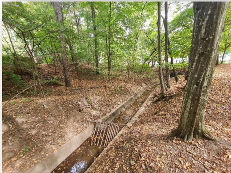
2 -Canal de colectare a apelor pluviale (în partea de vest a orașului Pitești)
